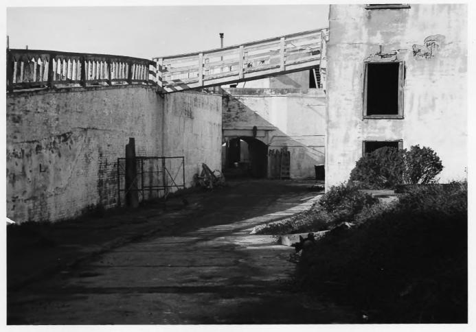
THE "LOVERVED WAY" OF NORTH BATTERY, NOTE THE REVERSE WALL OF BRICK ON THE LEFT, AND THE ARCH OF A MAGAZINE TRAVERSE C. 1872; AT RIGHT ARE THE INTRUSIVE REMAINS OF THE 1910 POWERHOUSE AND QUARTERMASTER'S GARAGE.
