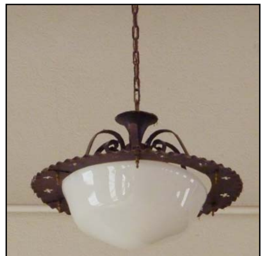
Type D, Room 126 (Auditorium)
