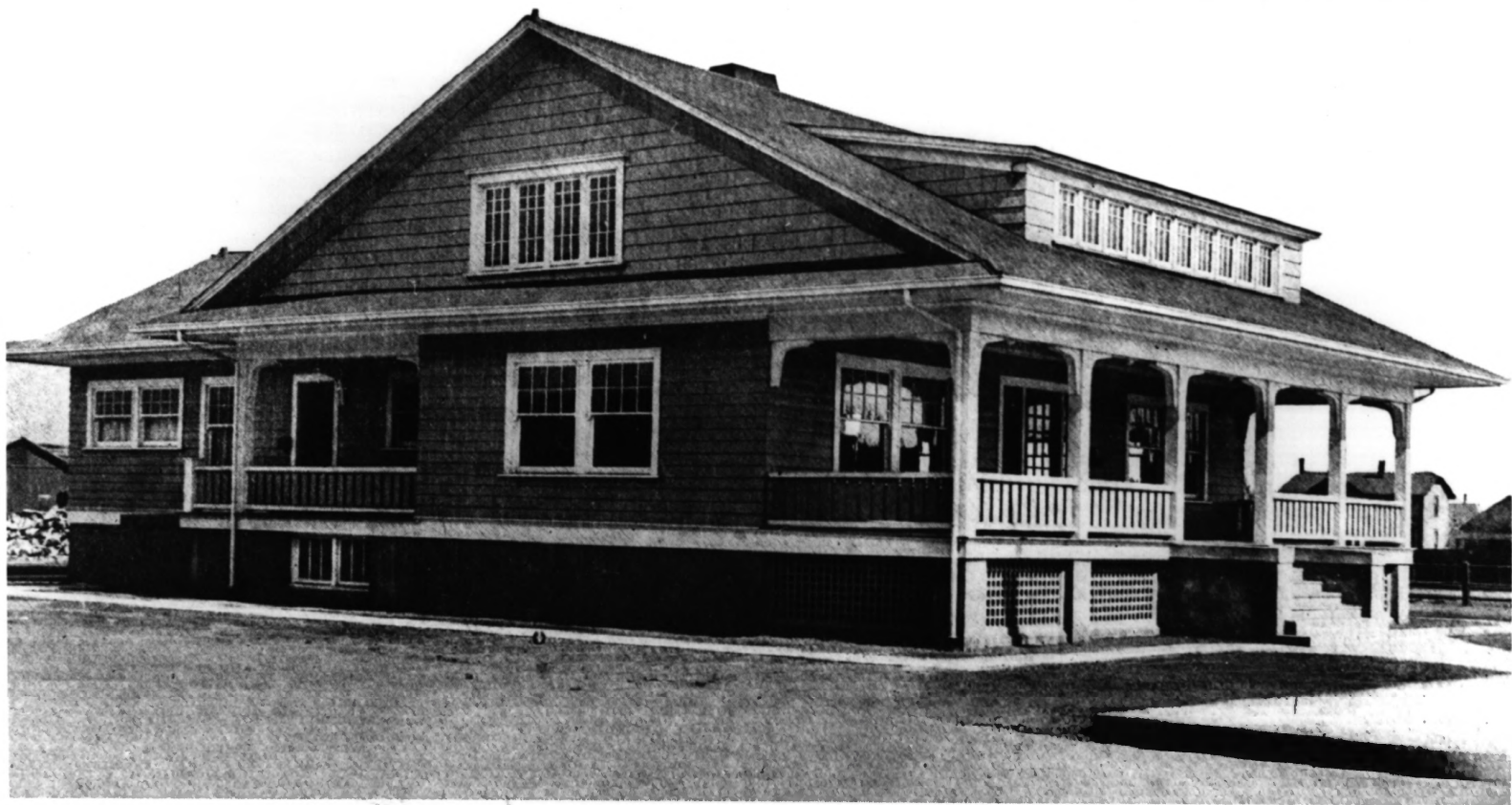
RAILROAD HOSPITAL. LA GRANDE. OREGON.
