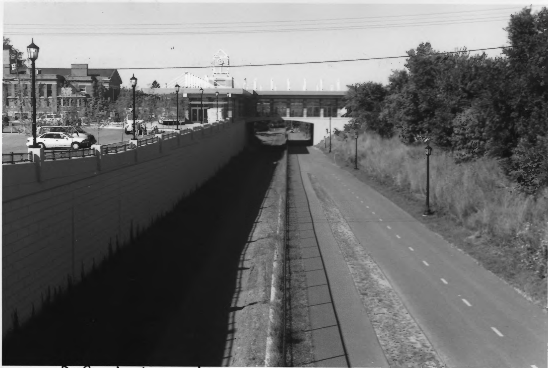
CM + STP Grade Separation Hennepin Co., MN 014510-24A
