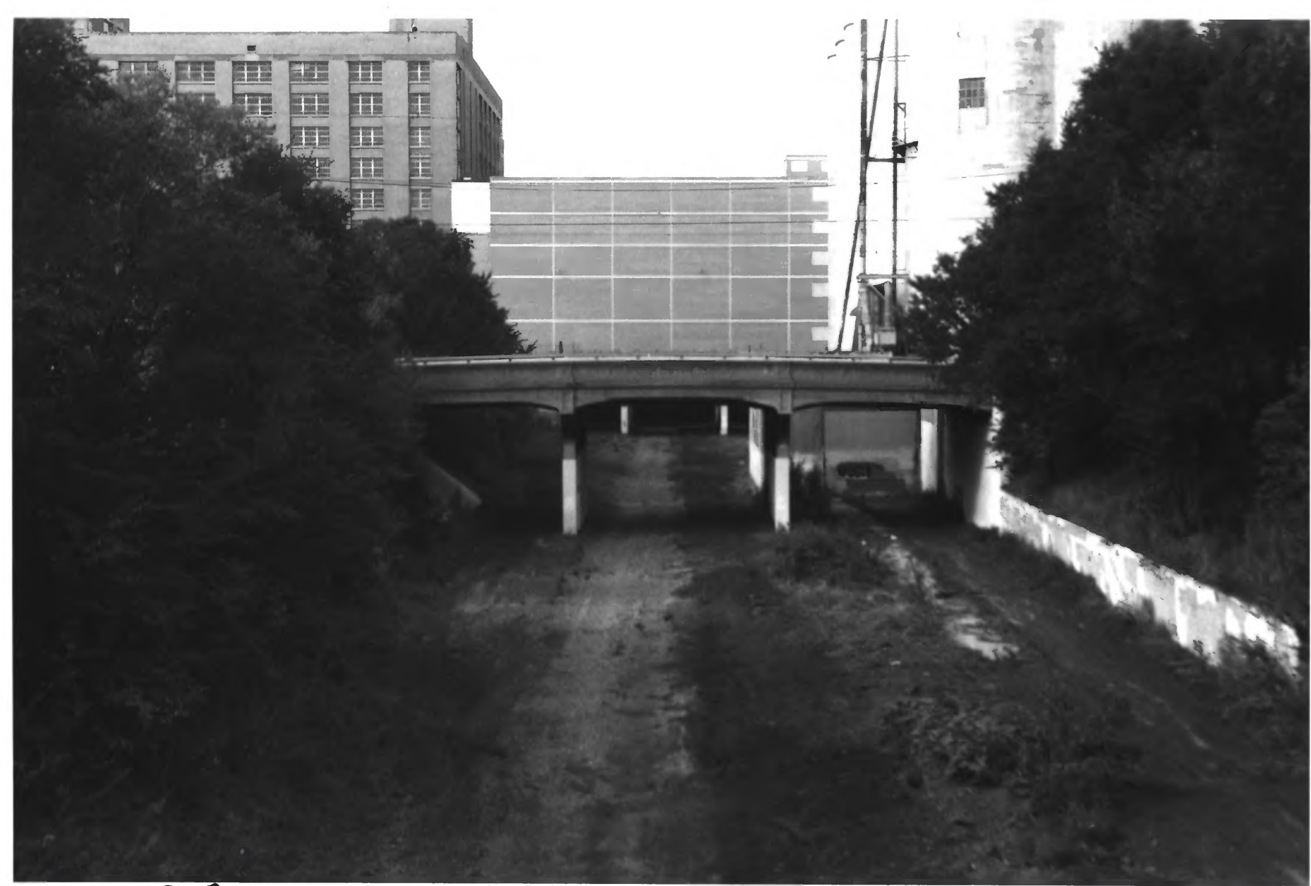
CM + STP Grade Separation Hennepin Co., Mn 014508 - 18118A
