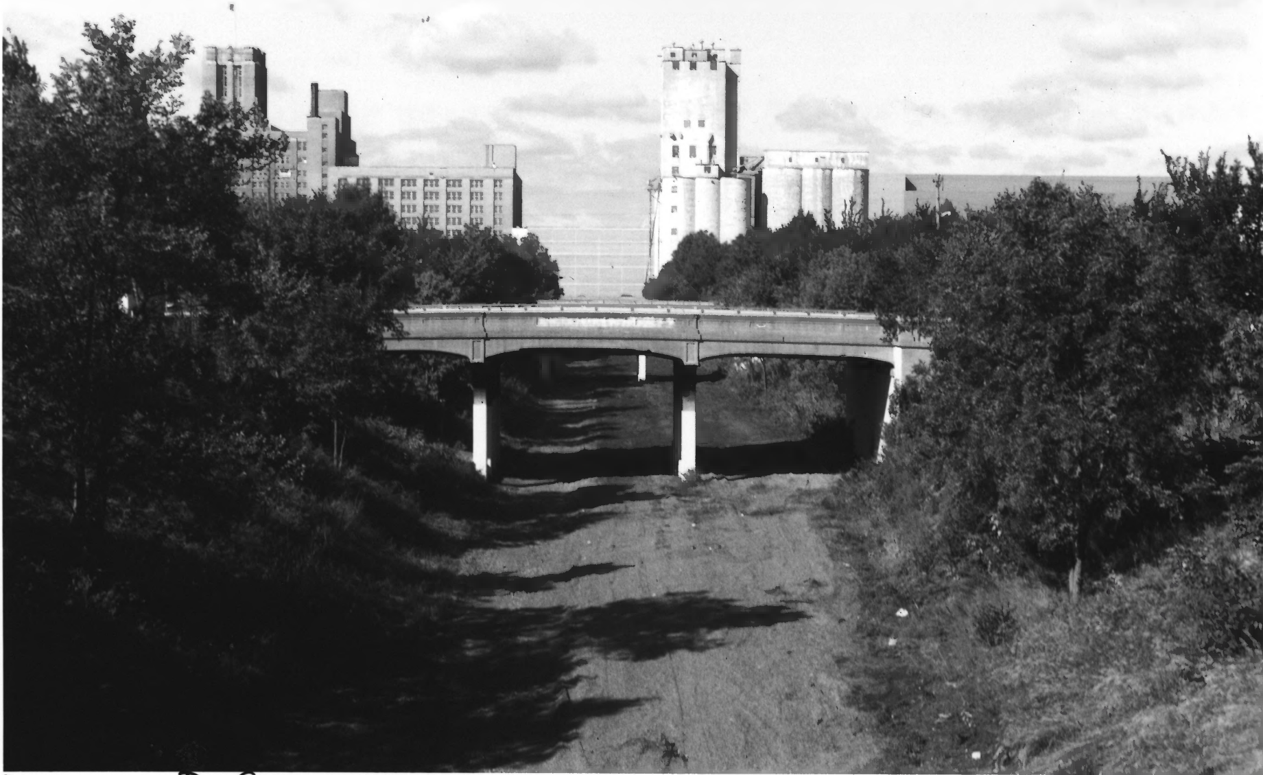
CM + STP Grade Separation Hennepin Co., Mn 014508 - 11/11A
