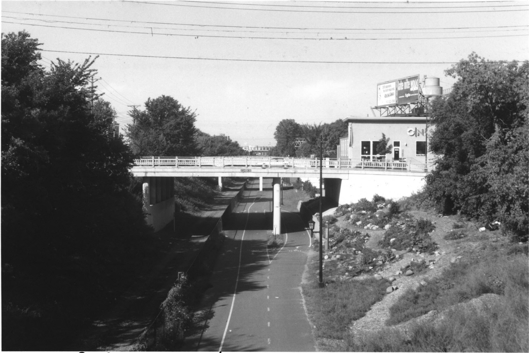
CM + St P Grade Separation Hennepin Co., Mn 014510 - 9A110
