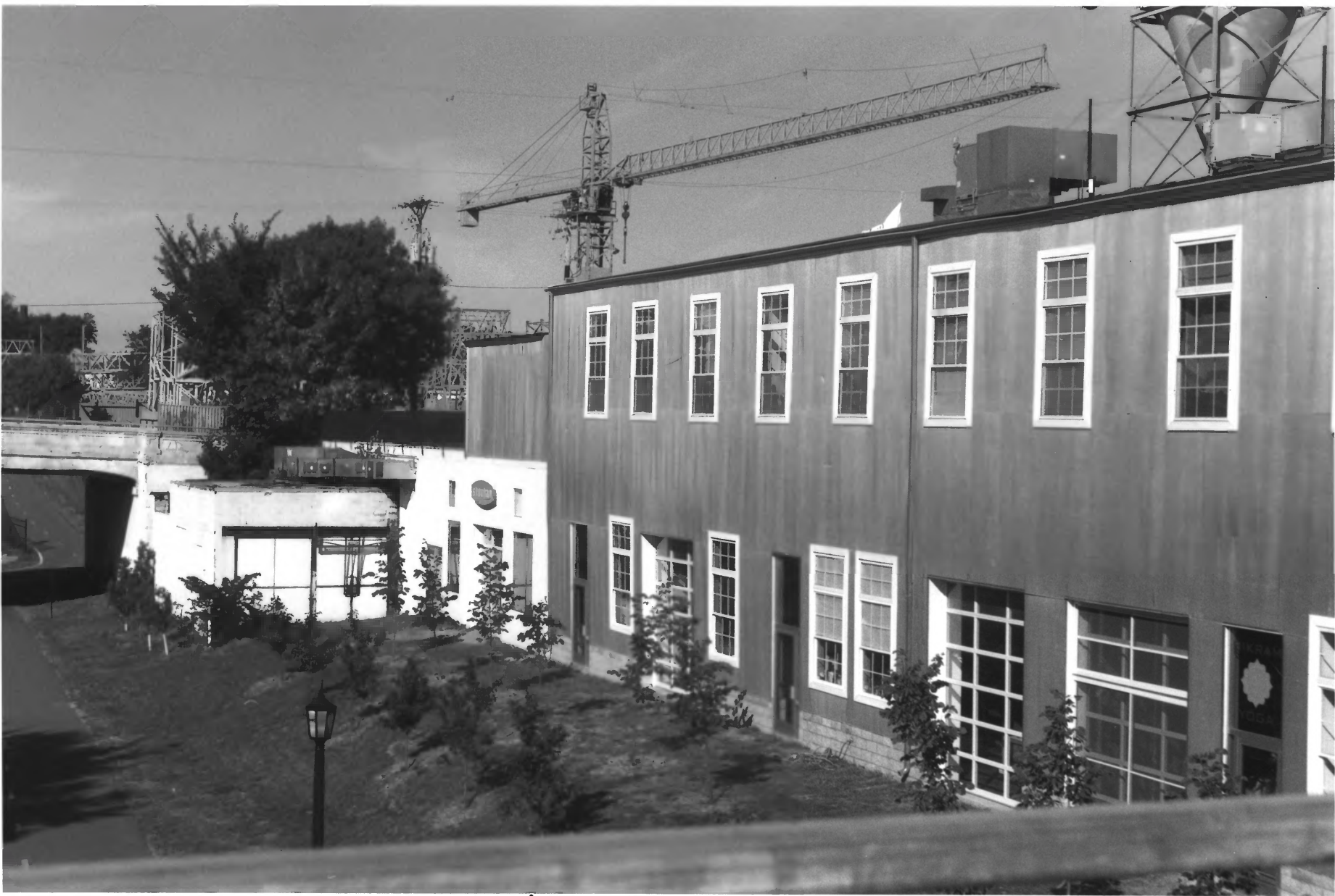
CM + StP Grade Separation Hennepin Co., MN 014510-10A/11
