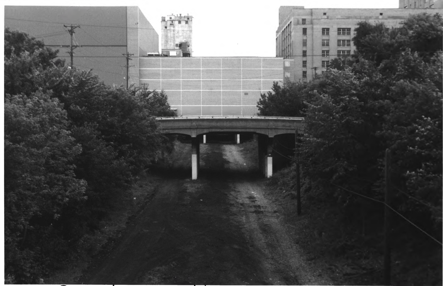
CM + STP Grade Separation Hennepin Co., MN 014509-414A
