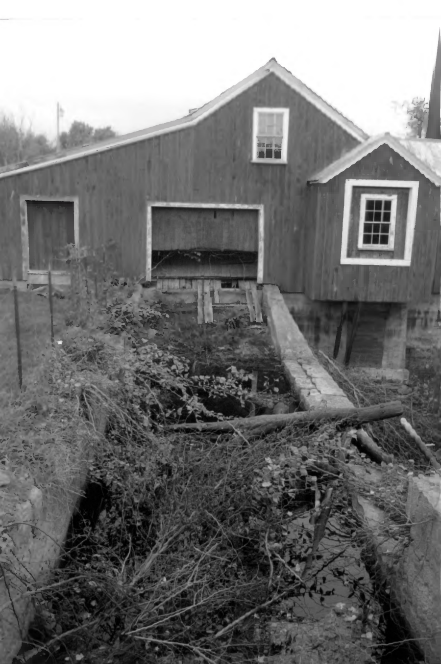
DENNIS JOHNSON LUMBER CO. MILL, YORK CO., ME
