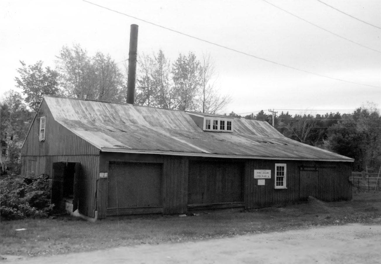
DENNIS JOHNSON LUMBER CO. MILL; YORK CO., ME
