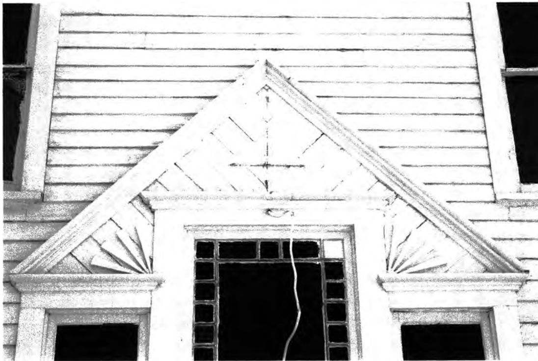
Façade tripartite window trim.
