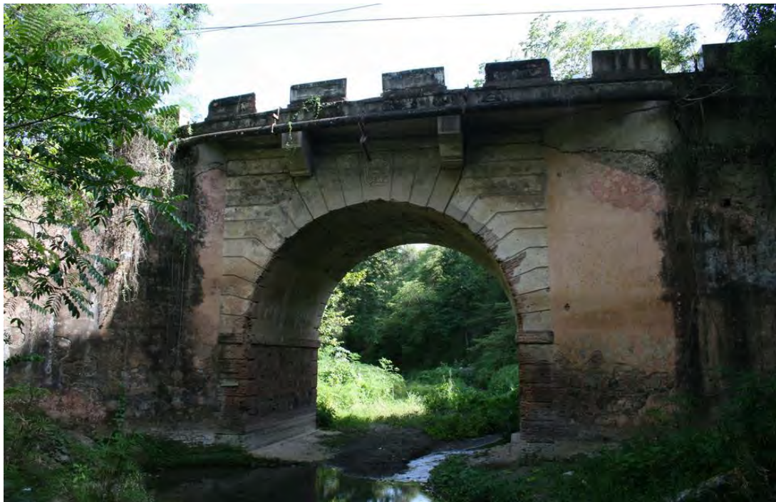
Puente Méndez Vigo (Puente Las Minas), Coamo, PR-14, km. 30.4 (b.1862)
