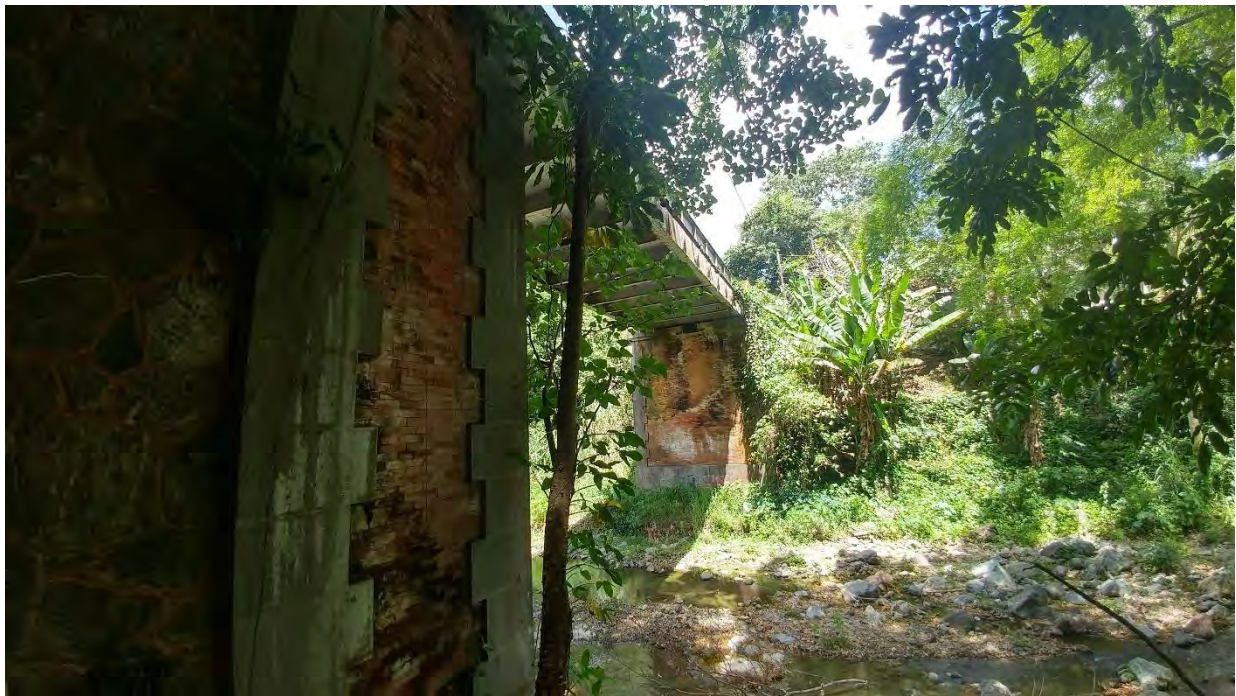
Puente Río Matón, Cayey, PR-14, km. 63.2 (b.1886)
