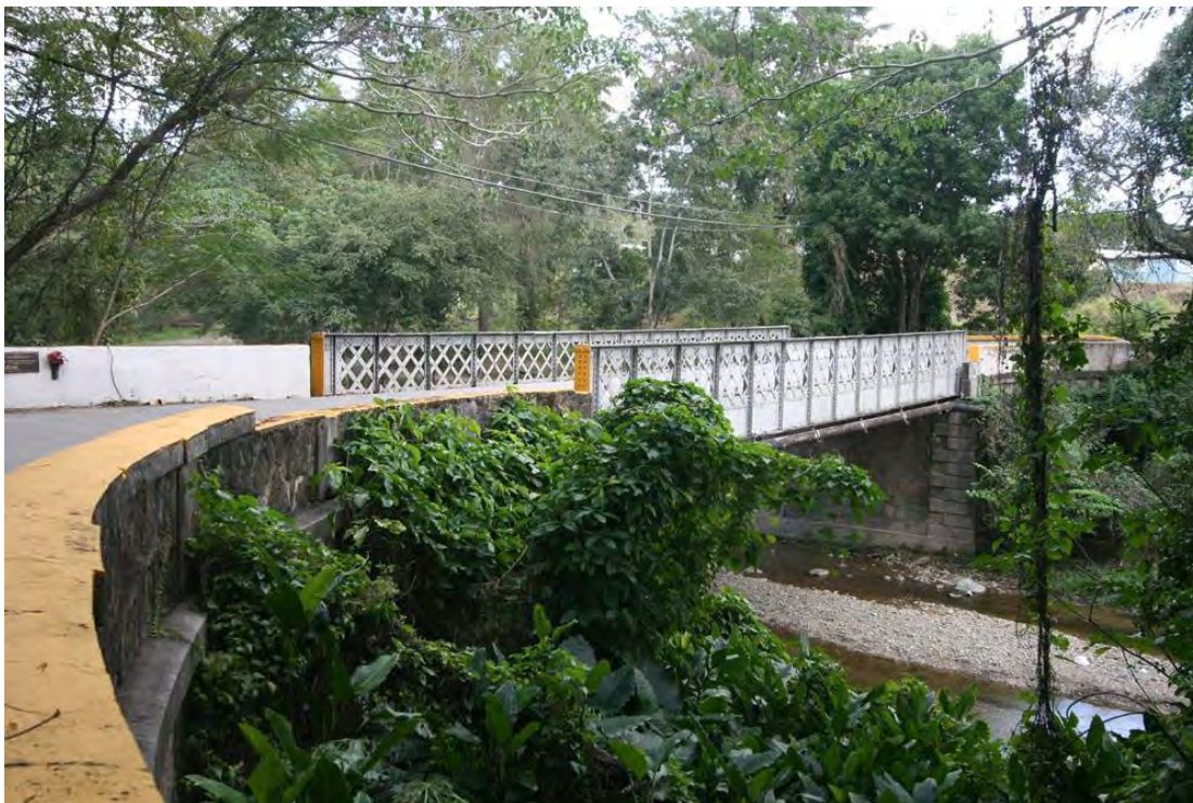
Puente de Las Calabazas, Coamo, Km.38.8 (1882)
