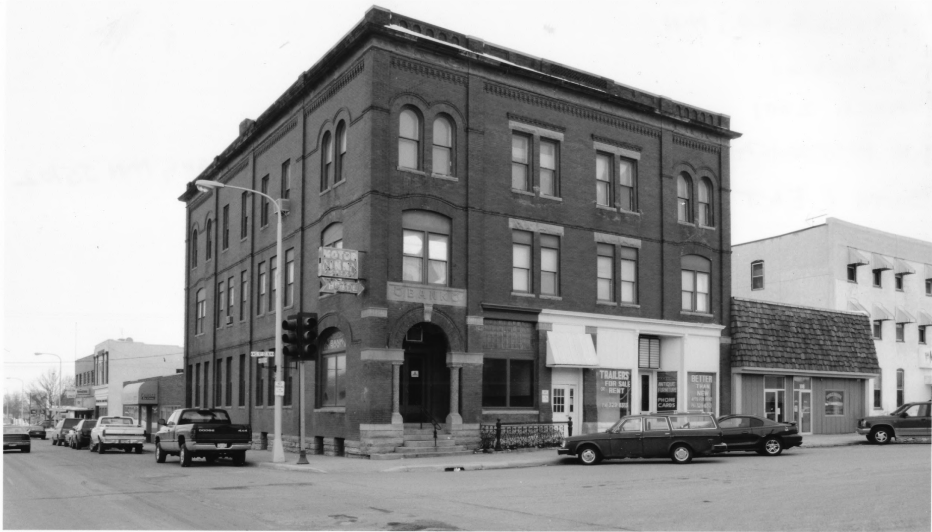
HEINS BLOCK RENVILLE CO., MN 013874-22A
