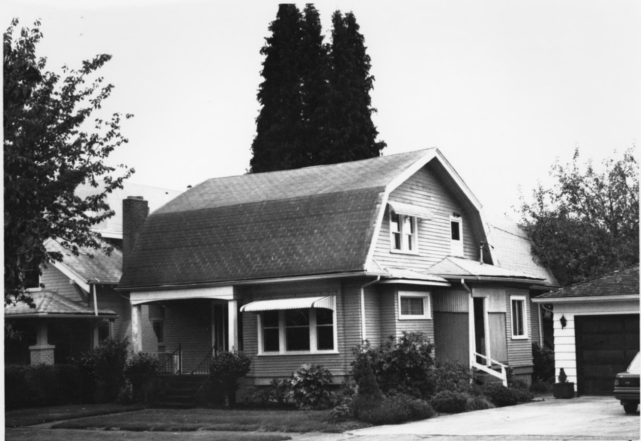
1606 S. COLUMBIA, WEST FACADE, S. CAPITOL NEIGHBORHOOD H. D. # 55
