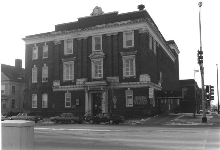
Winona Masonic Temple, Winona Winona Co., Mn 011088-6A17
