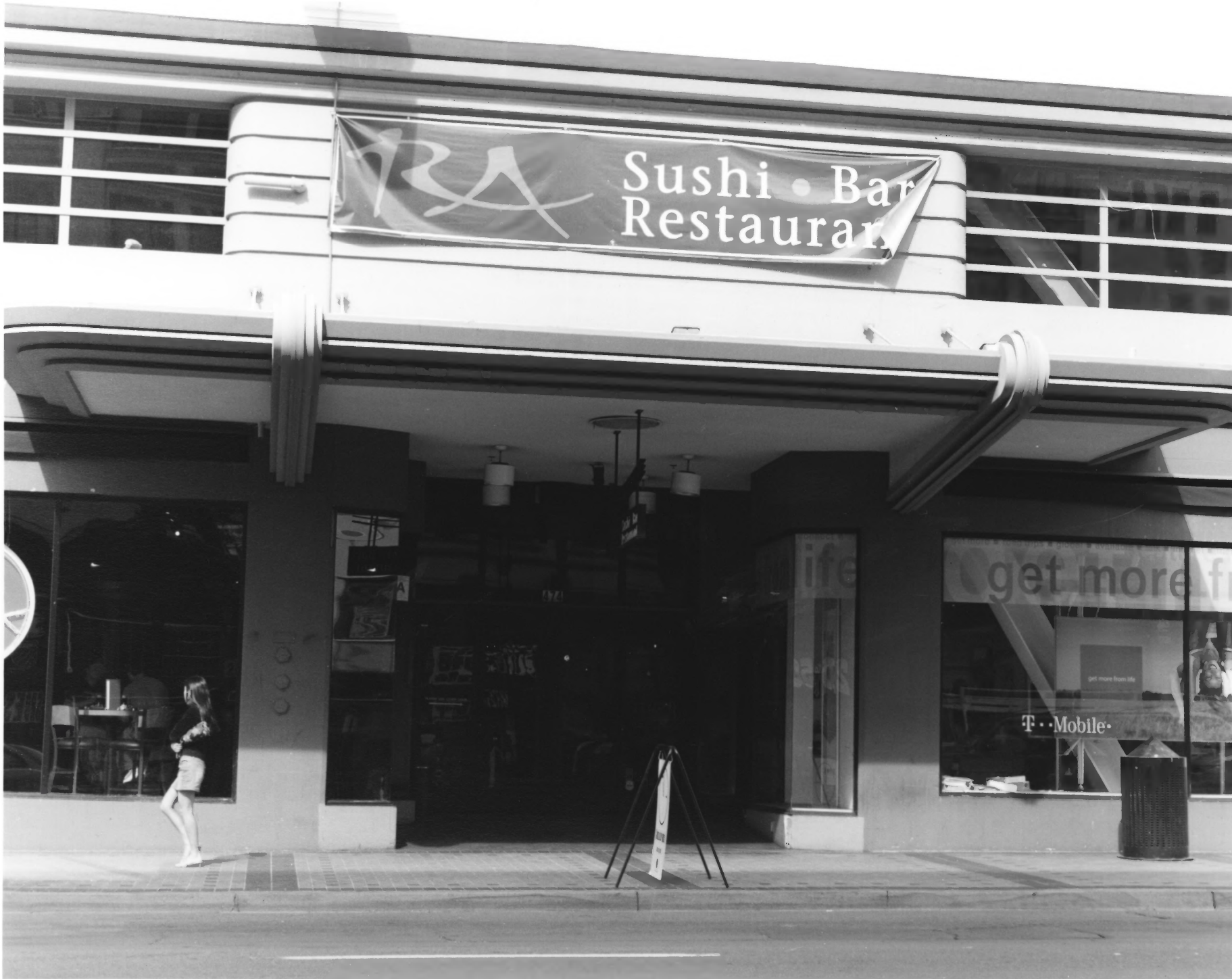
S. HOLZWASSER/WALKER SCOTT, SAN DIEGO, CA
