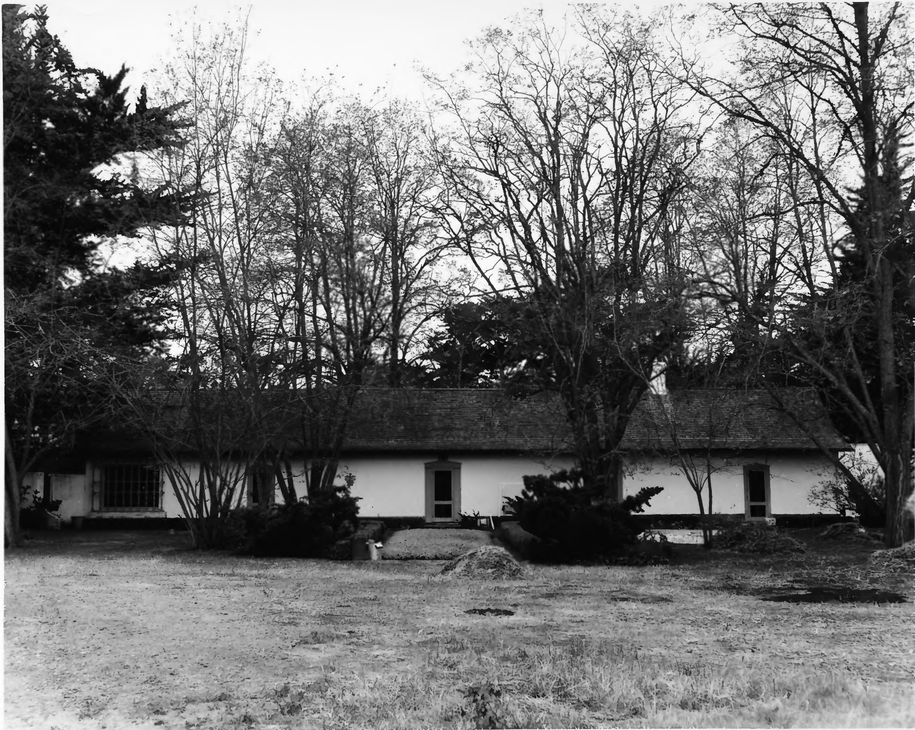
Los Alamos Ranchhouse, Los Alamos, California
