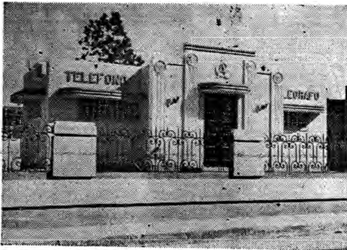
Edificio del Teléfono Automático en Juncos y Guaynabo.
