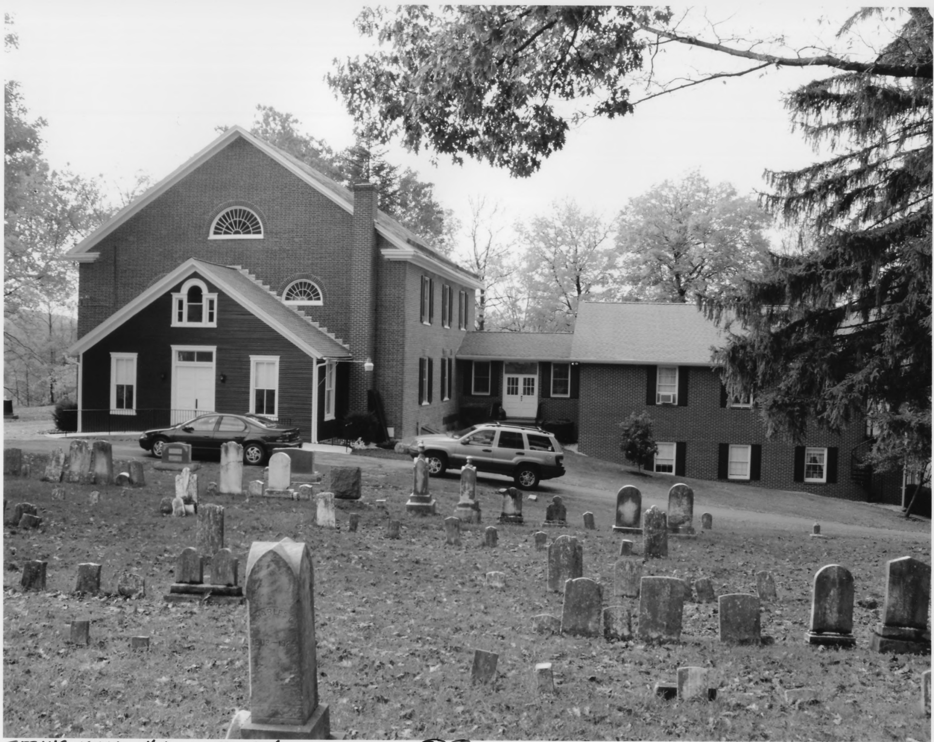
SPRING MILLS H.D., Berkeley Co. WV (2) (4)
