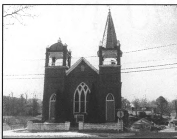
East Façade (N. Jackson St)
