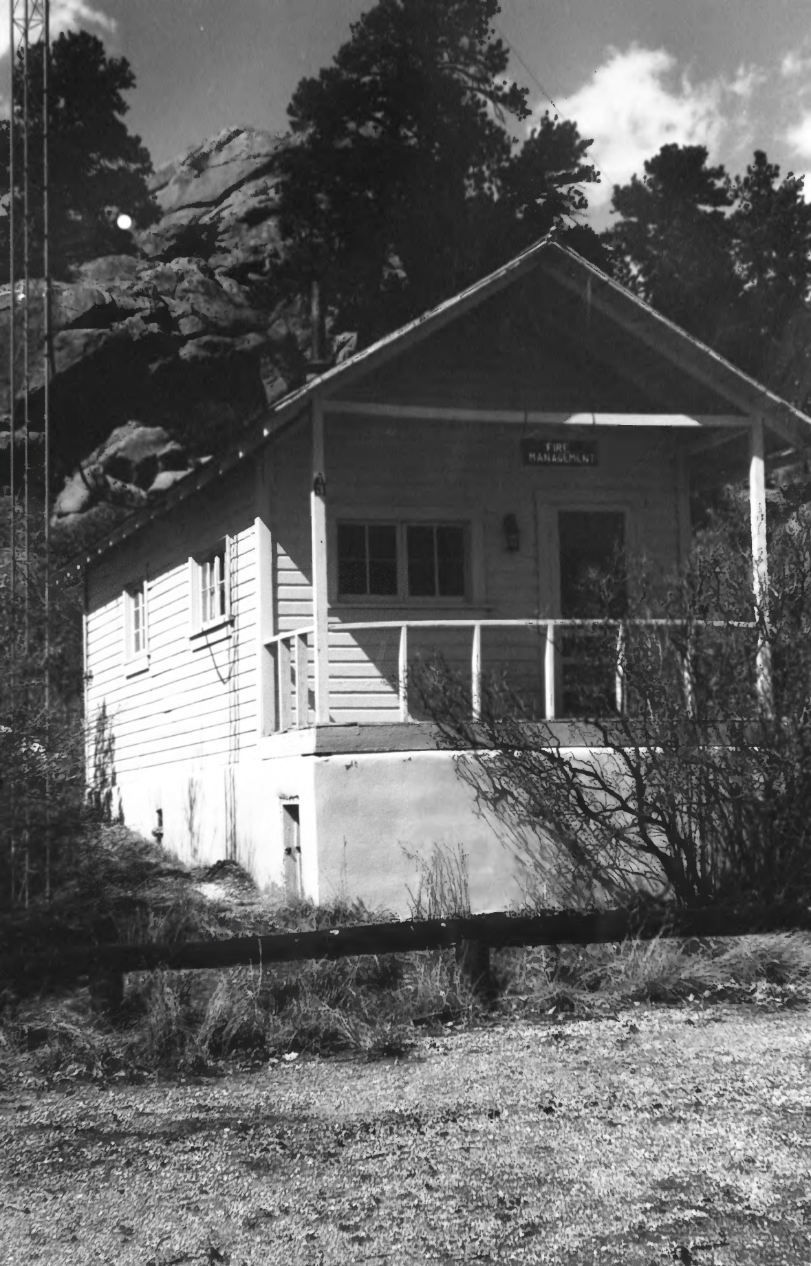
TRES PIEDRAS RANGER DISTRICT TAOS CO., NM PHOTO # 10
