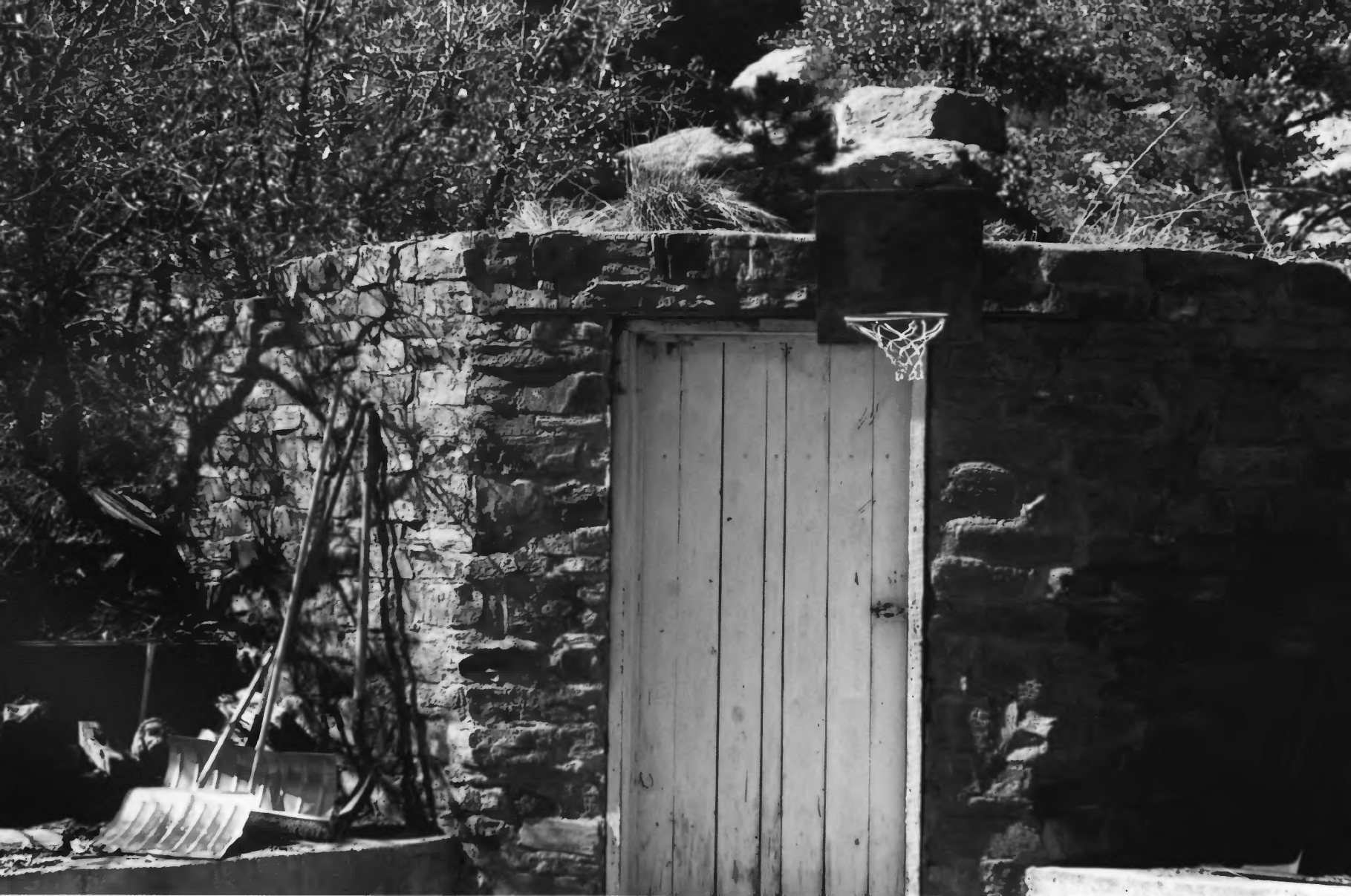
TRES PIEDRAS RANGER DISTRICT TAOS CO., NM PHOTO # 9
