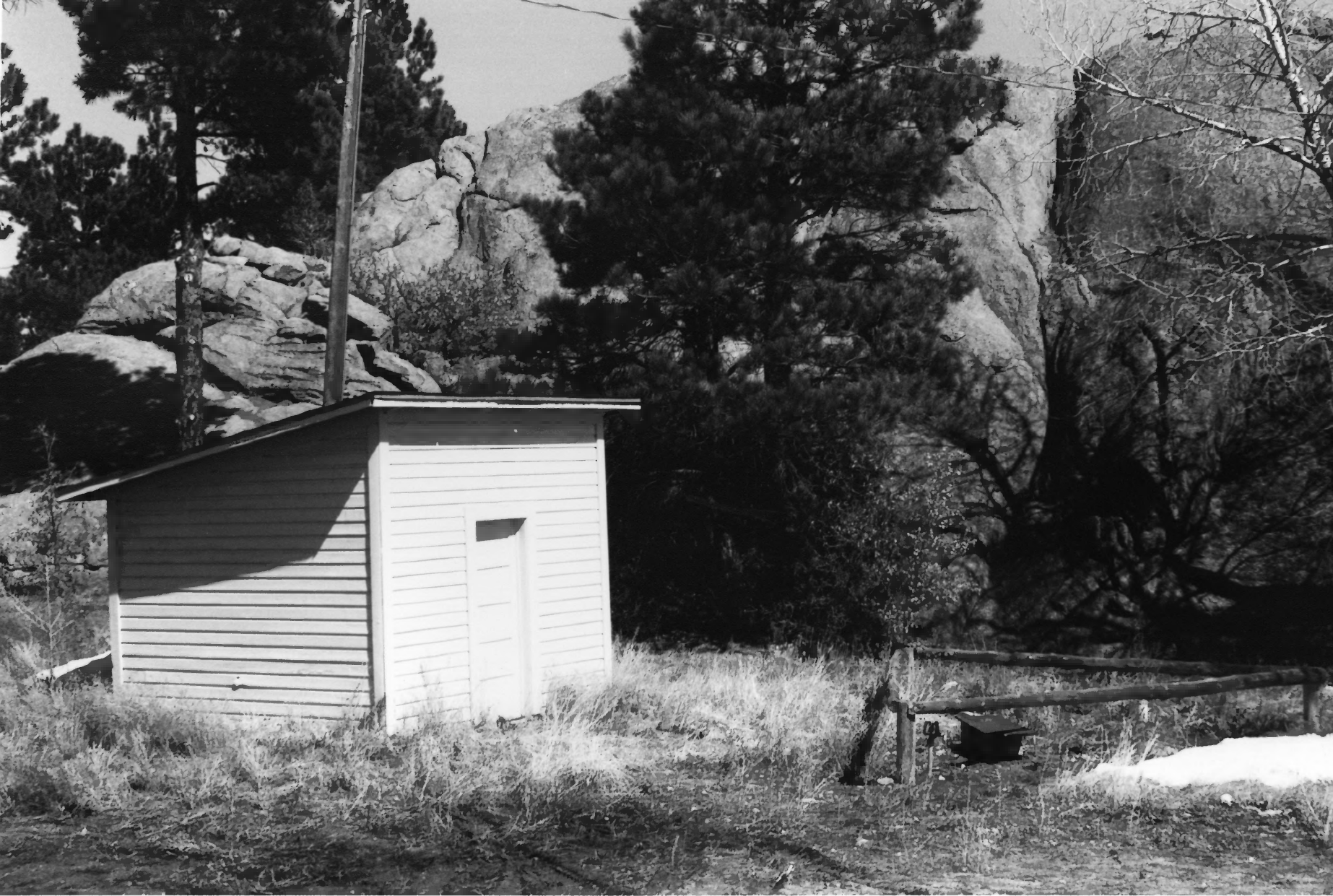
TRES PIEDRAS RANGER DISTRICT TAOS CO., NM PHOTO # 16
