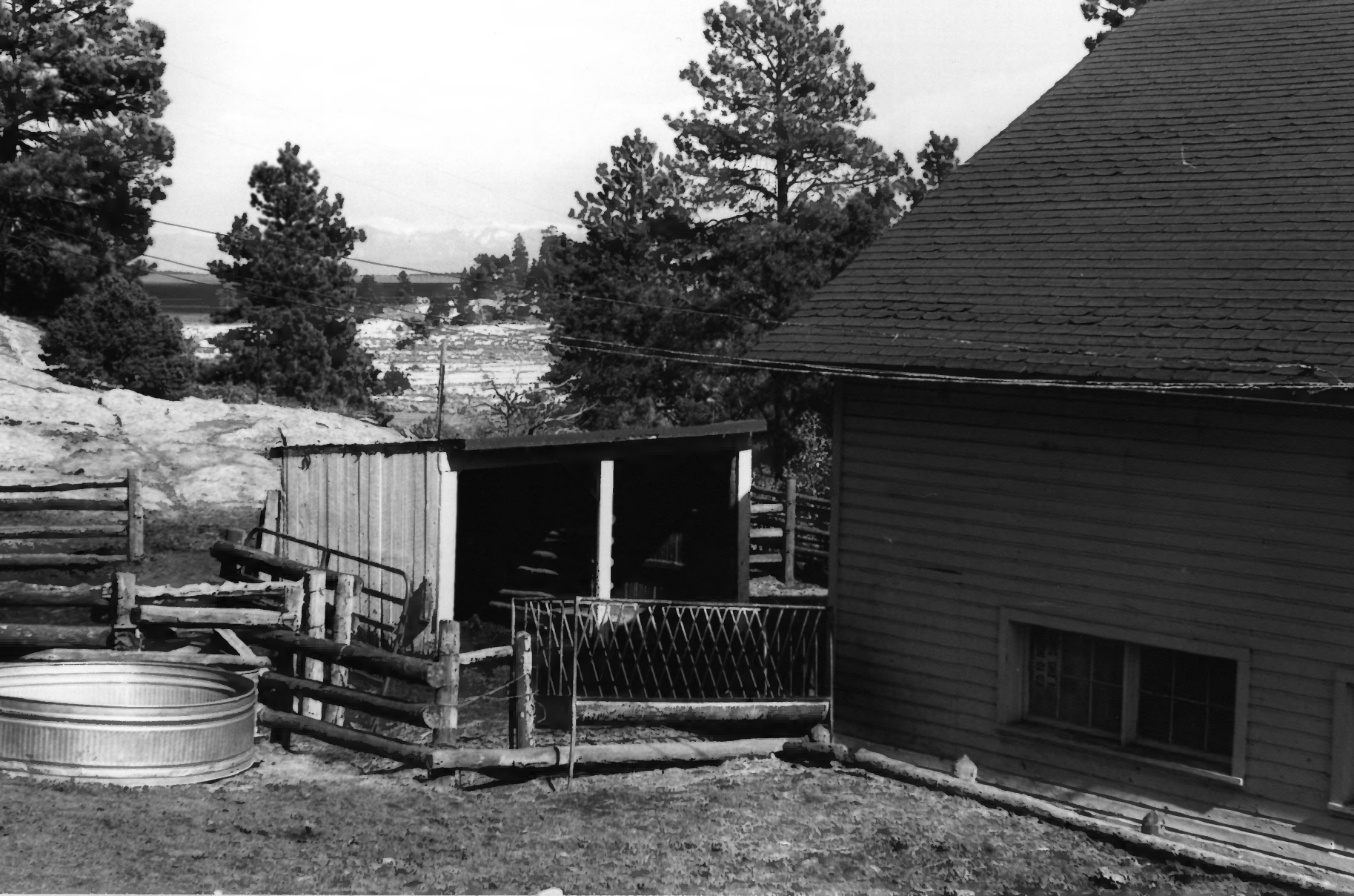
TRES PIEDRAS RANGER DISTRICT TAOS CO., NM PHOTO # 14
