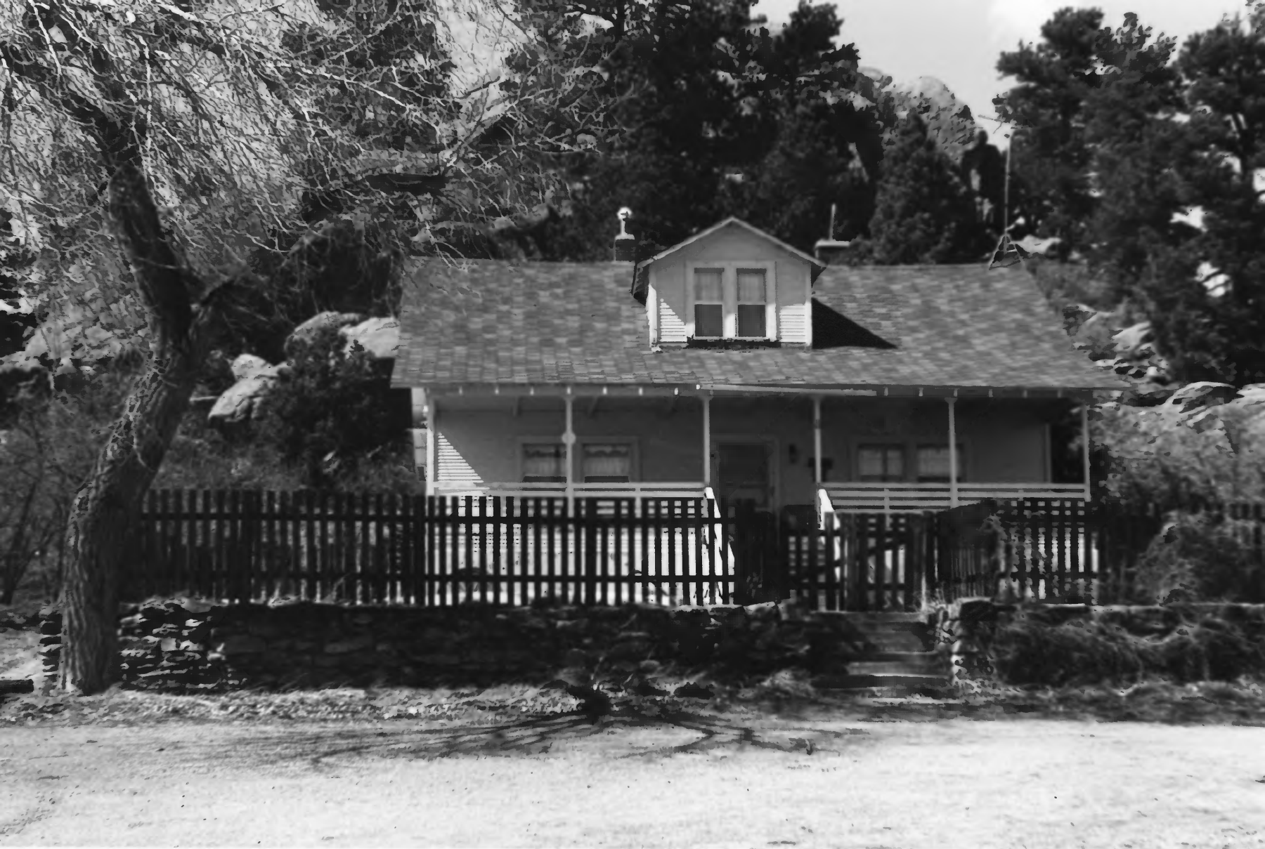
TRES PIEDRAS RANGER DISTRICT TAOS CO., NM PHOTO # 6
