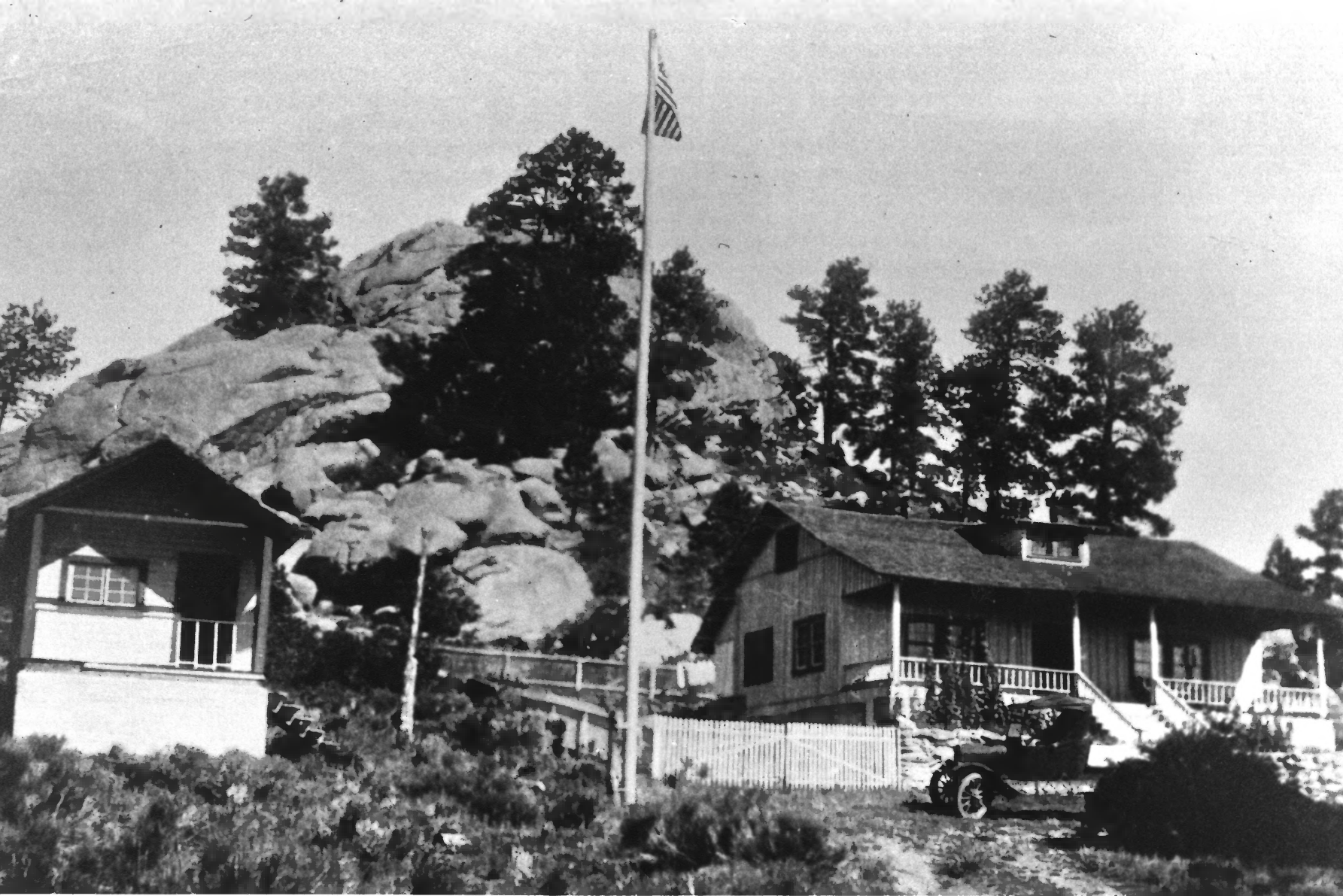
TRES PIEDRAS RANGER DISTRICT TAOS CO., NM PHOTO # 5
