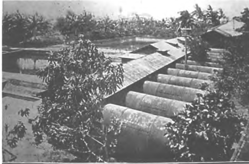
Los grandes filtros por donde circulan las aguas antes de ir a los depósitos.
