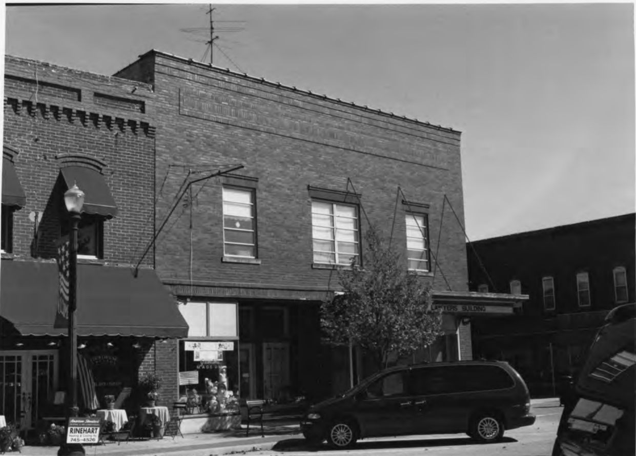
DANVILLE COURTHOUSE S.Q. H.D.
