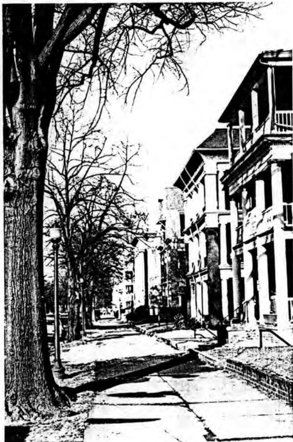
9 - 300 block N. Boulevard; view looking NE
