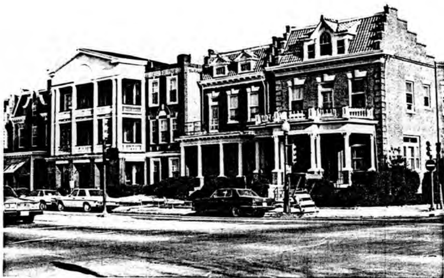
13 - 10 block N. Boulevard; view looking NE
