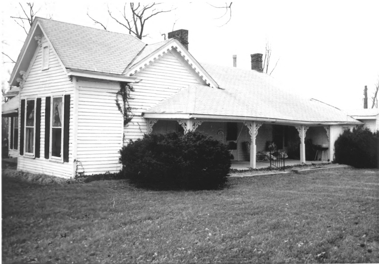
STBELLE, DREWSILLA, HOUSE
