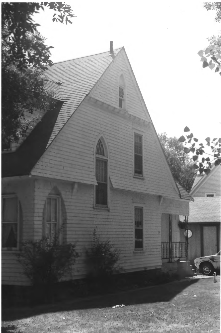
Amy A. Davis House, Codrington Co., S.D., No. 2
