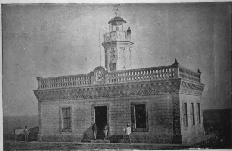
Faro del Puerto de Guáguara.
