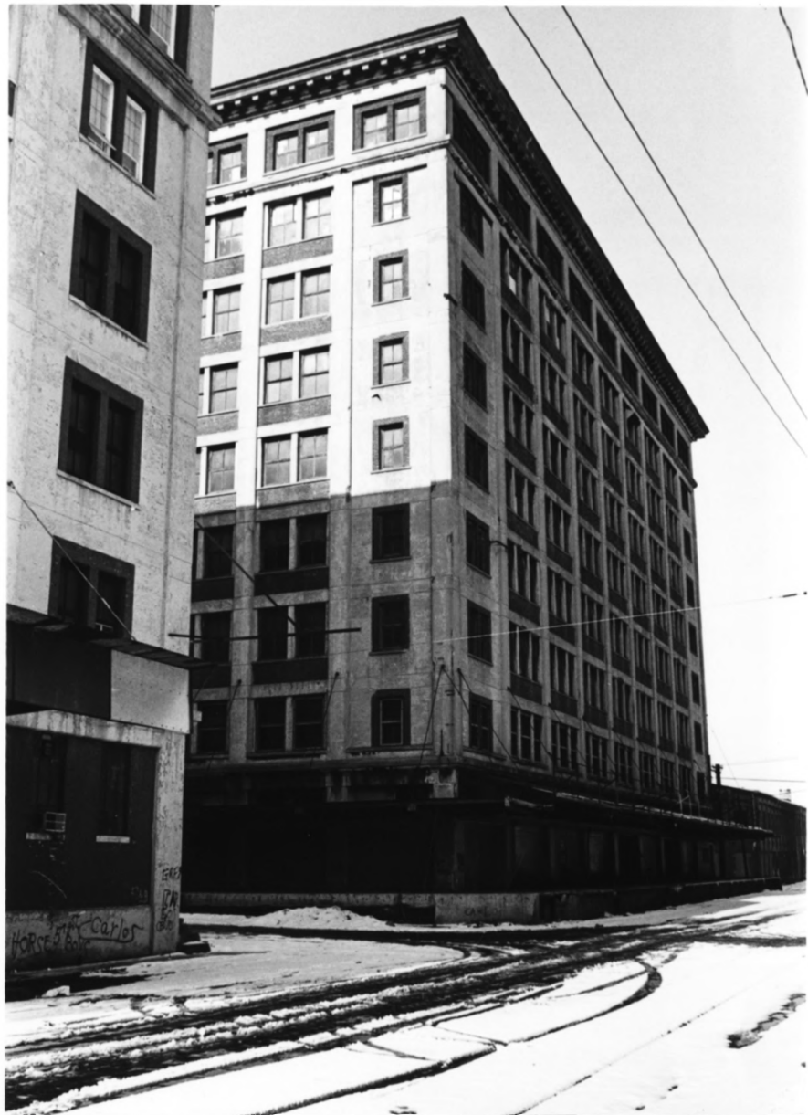
A. & P. WAREHOUSE
