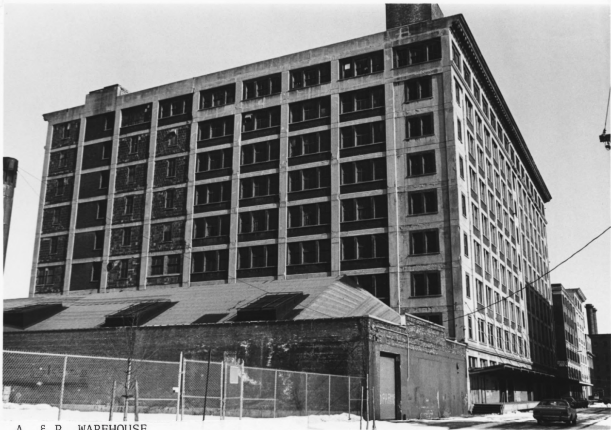
A. & P. WAREHOUSE
