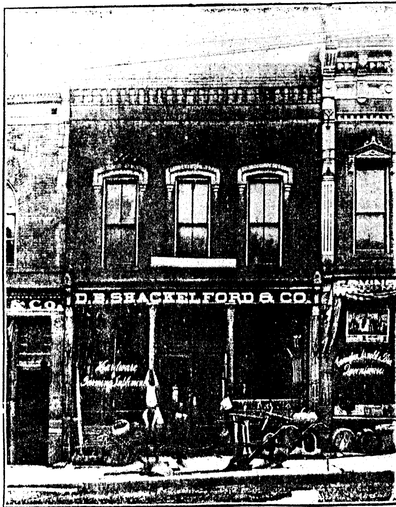
EXTERIOR OF D. B. SHACKELFORD & CO.
