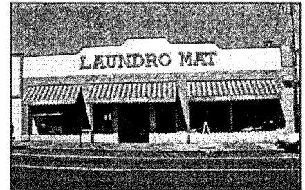
8111-8119 N. Denver Avenue
