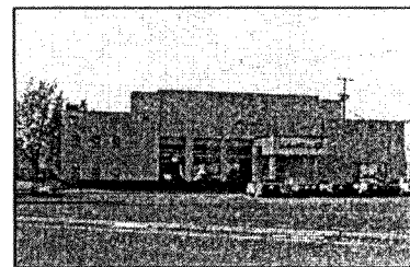
8324 N. Denver Avenue
