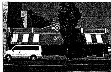
8329 N. Denver Avenue
