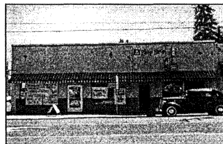
8238 N. Denver Avenue
