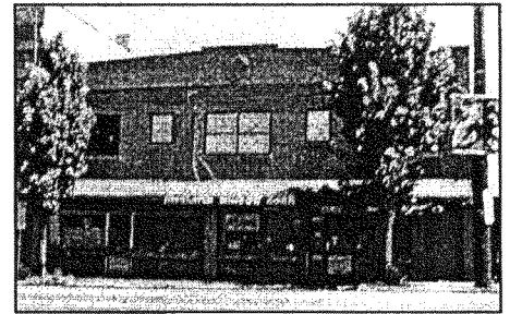
8120-8128 N. Denver Avenue
