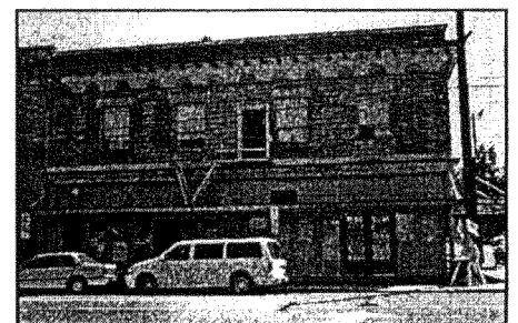
8202-8208 N. Denver Avenue
