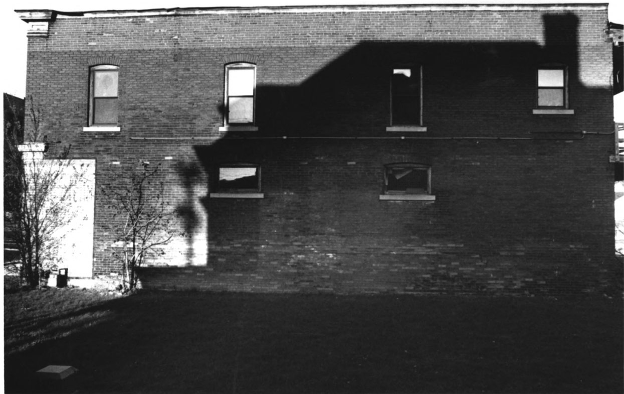
⑤ C. McCOORMICK BLDG, E. BANK MPL, S. BEND, IN
