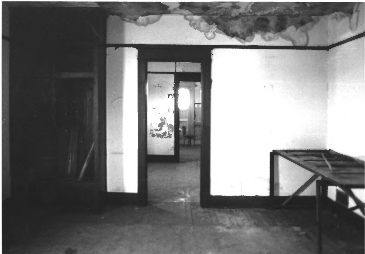
① C. McCormick BLDG, E. BANK, S. BEND, I. IN MPL.
