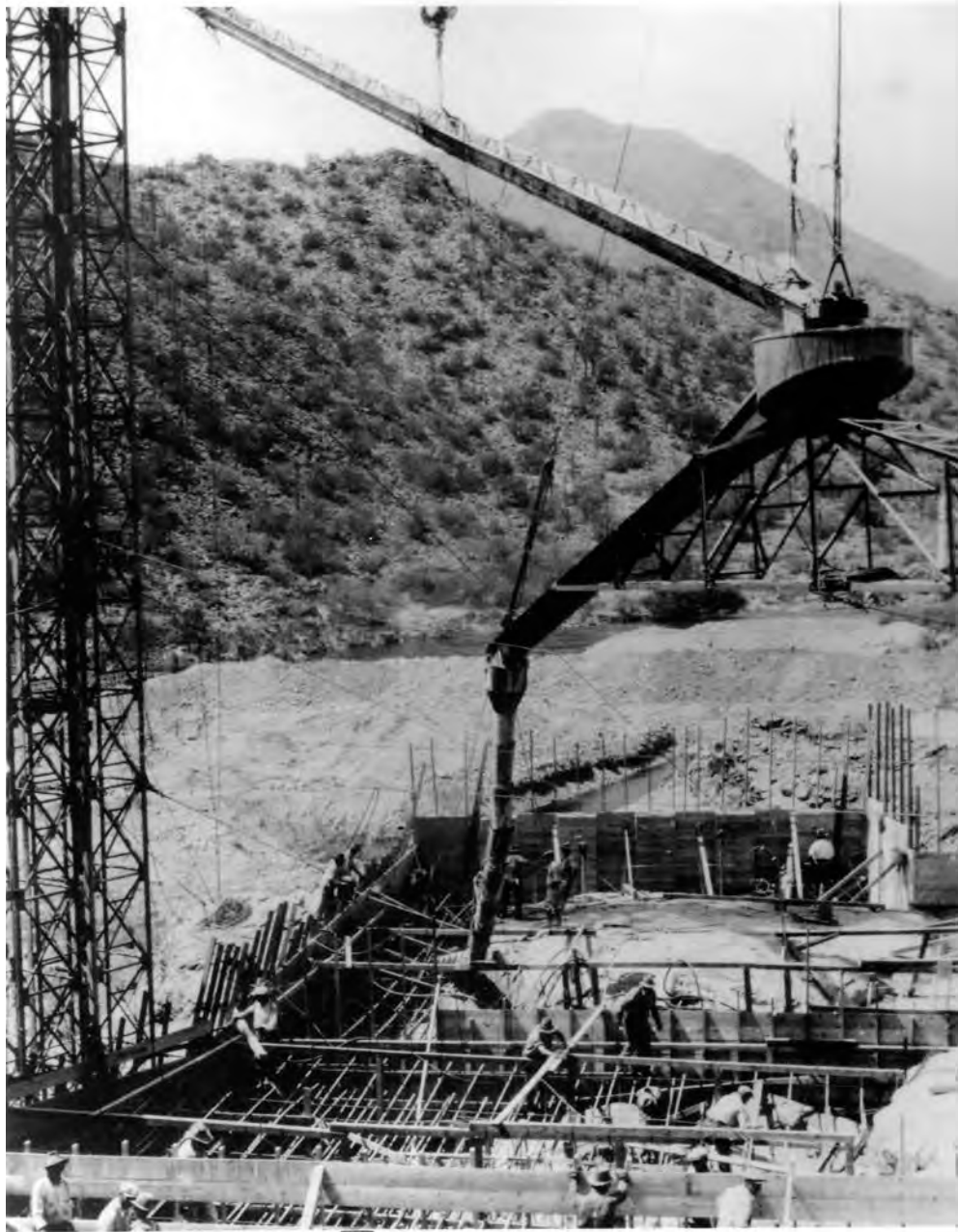
POURING CONCRETE. 19 April 1929.
