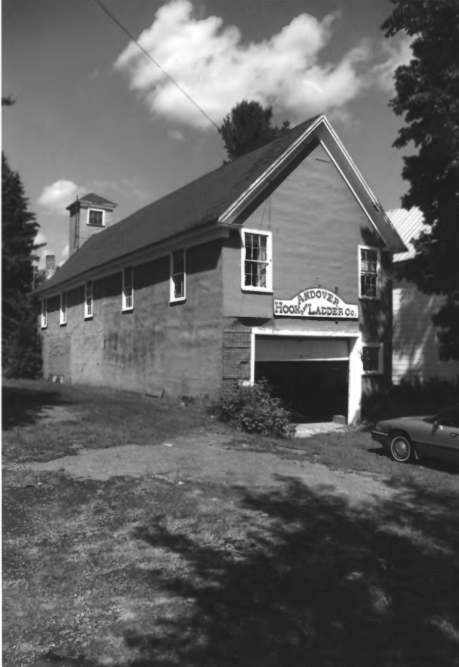
ANDOVER HOOK + LADDER CO. BLDG., OXFORD CO., ME 10FZ
