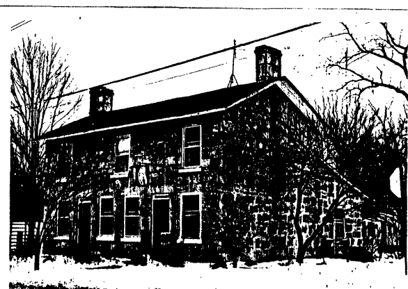
D. E. R. Guiberson House (W-50-W4)
