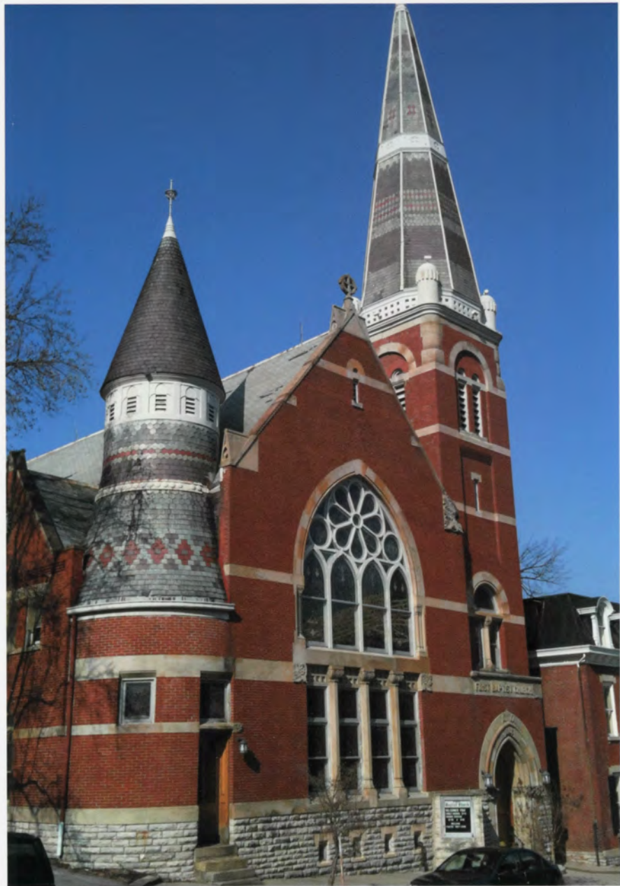
KY-MASON KY-COX BLDG-0013
