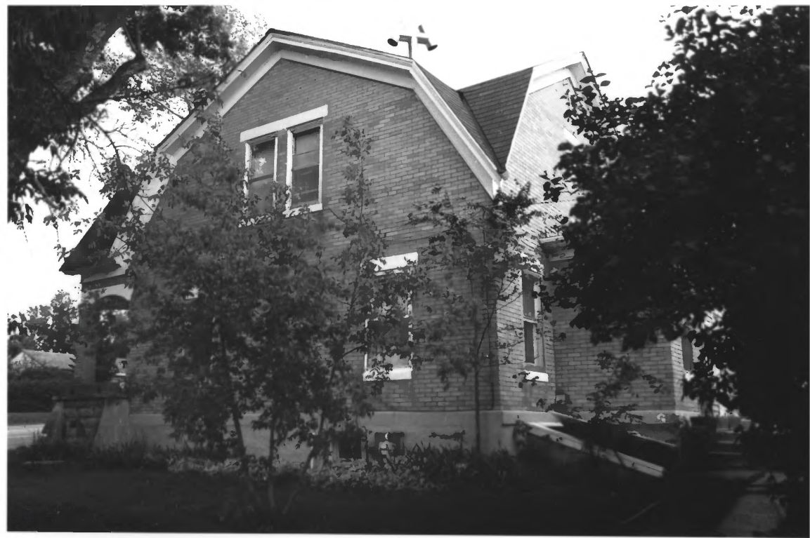
JAMES A. CORBIN HOUSE, LAWRENCE CO., S. D., NO 3.
