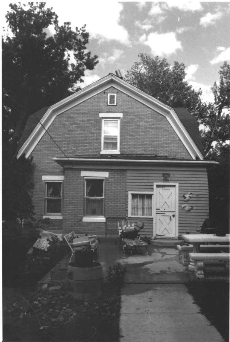
JAMES A. CORBIN HOUSE, LAWRENCE CO., S.D., NO. 4
