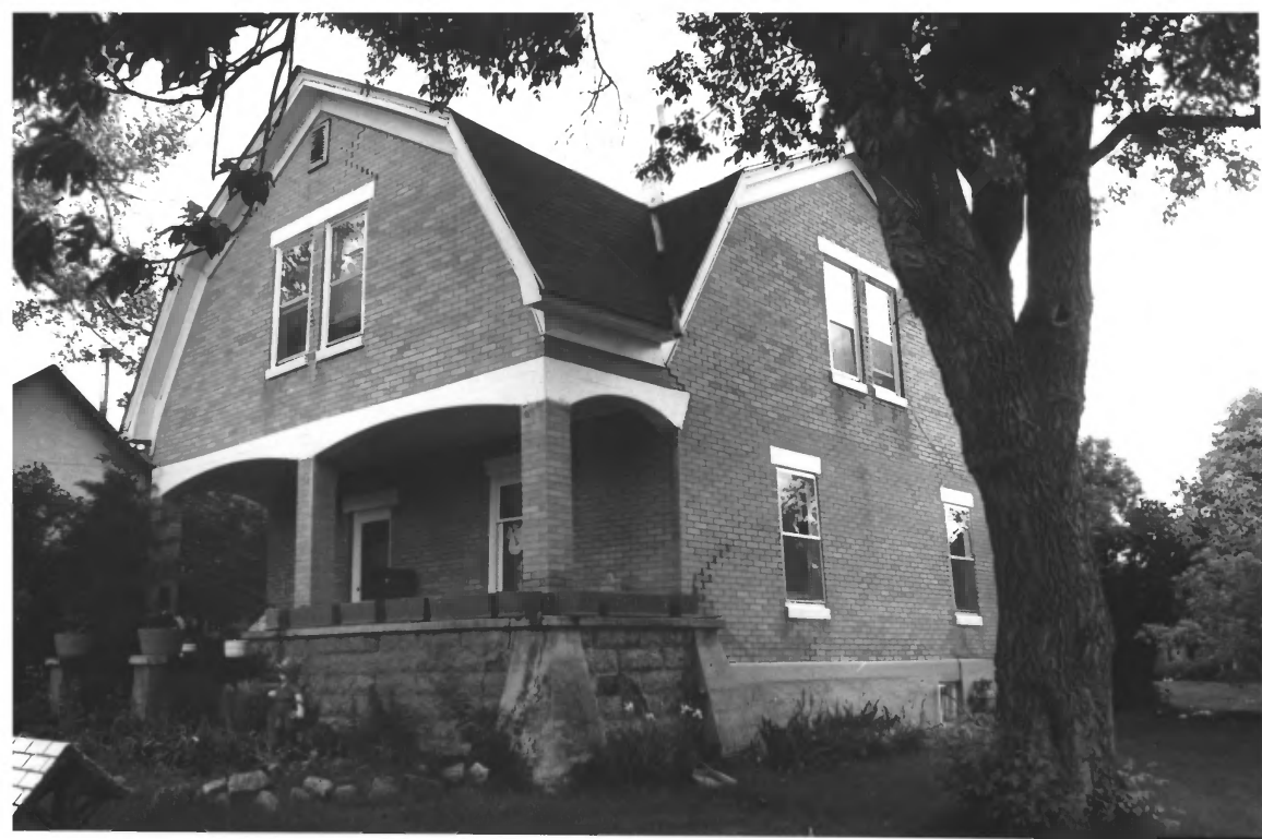
JAMES A. CORBIN HOUSE, LAWRENCE CO., S. D., NO. 2
