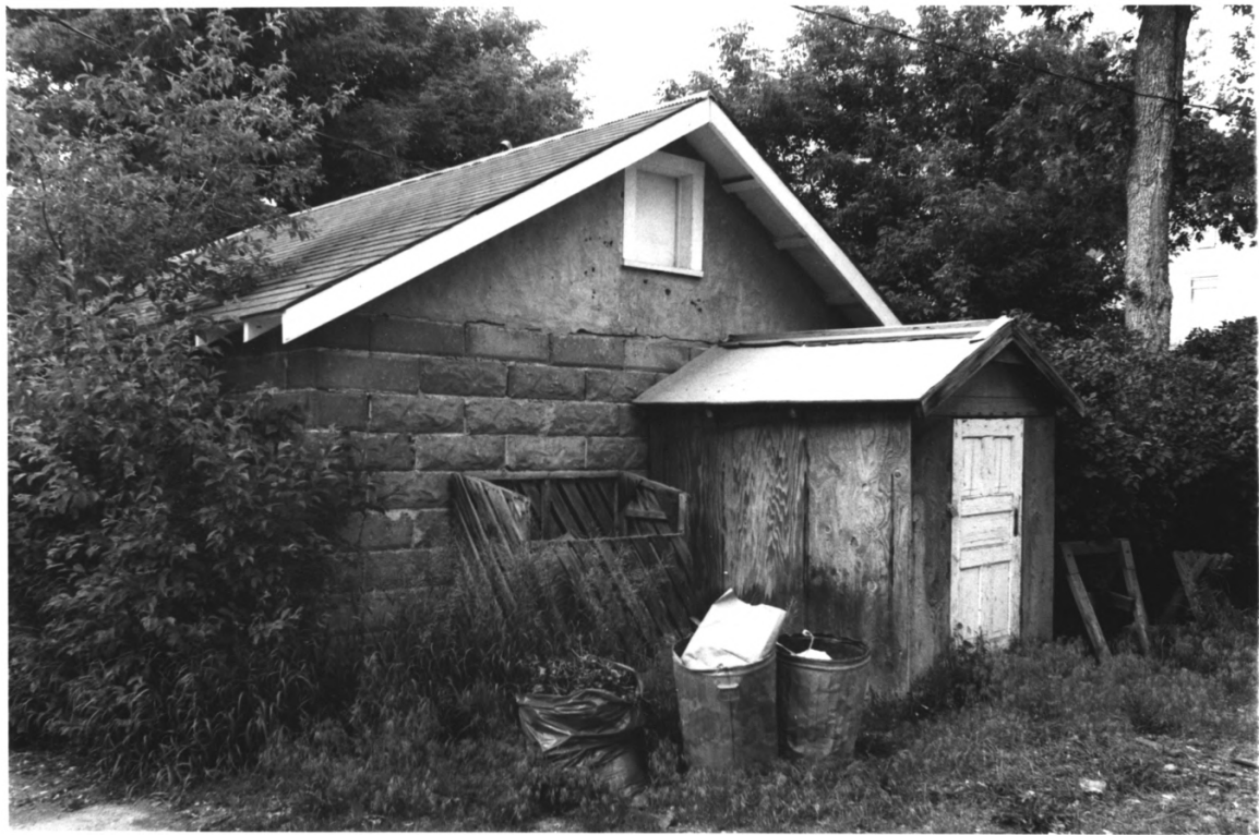
JAMES A. CORBIN HOUSE, LAWRENCE CO., S. D., NO. 6.
