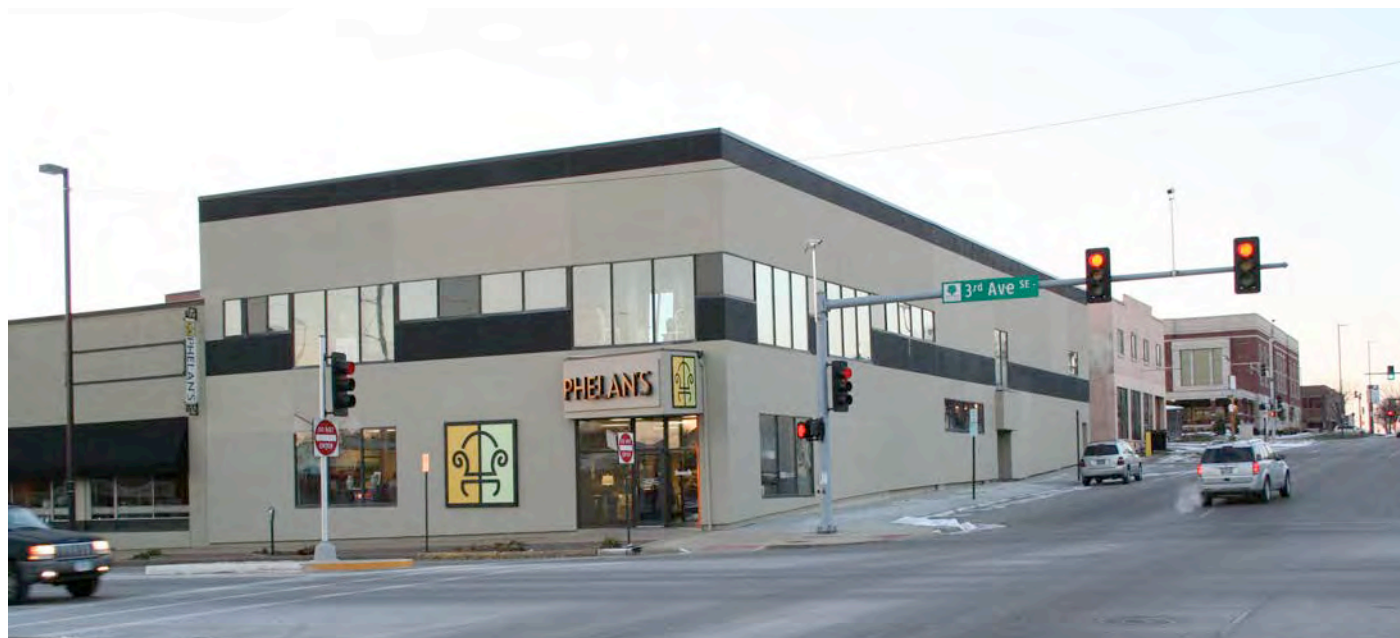
Image 43. 724 3 rd Avenue SE
