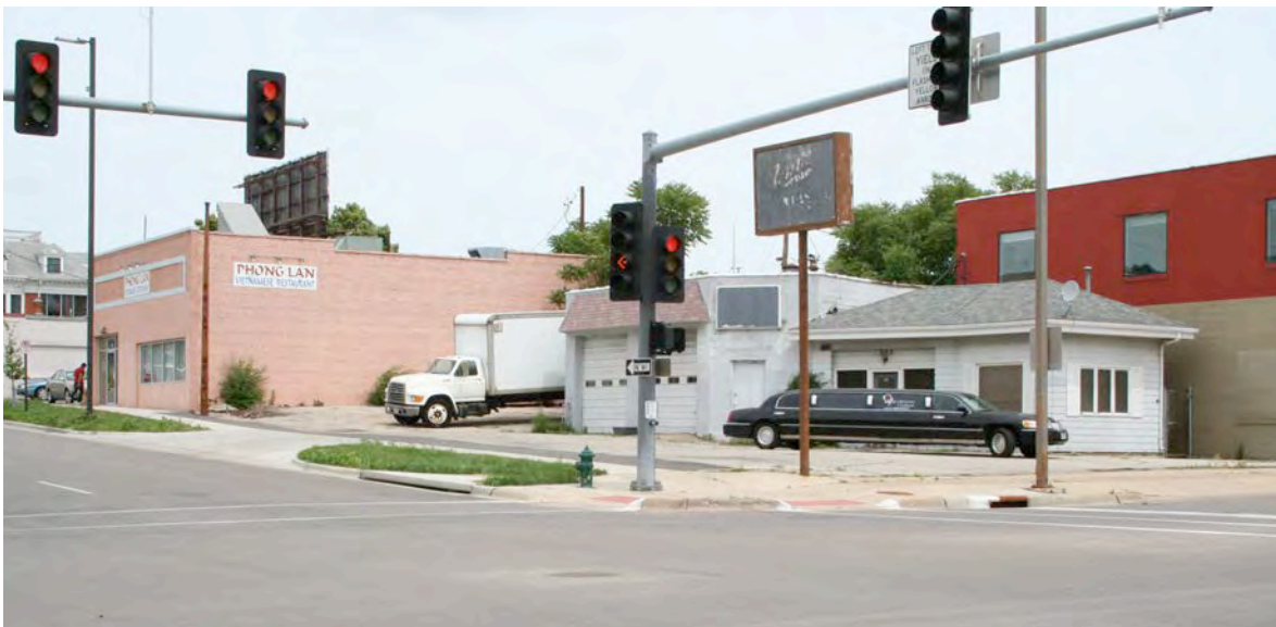
Image 45. 800 3 rd Avenue SE
