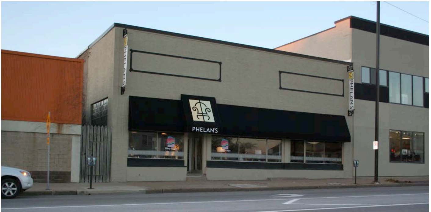
Image 41. 720 3 rd Avenue SE
