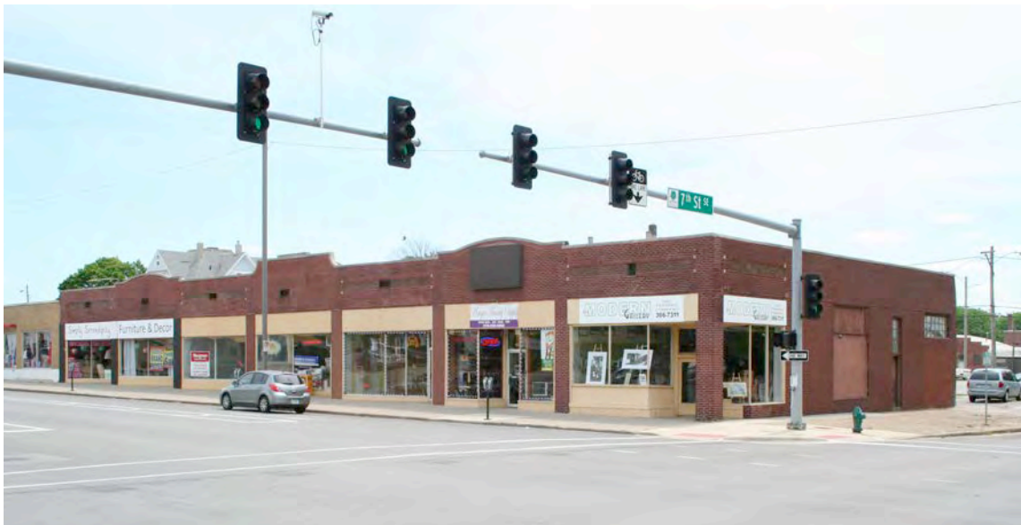
Image 46. 701-713 3 rd Avenue SE
