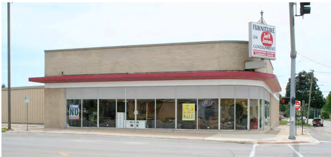
Image 49. 803 3 rd Avenue SE
