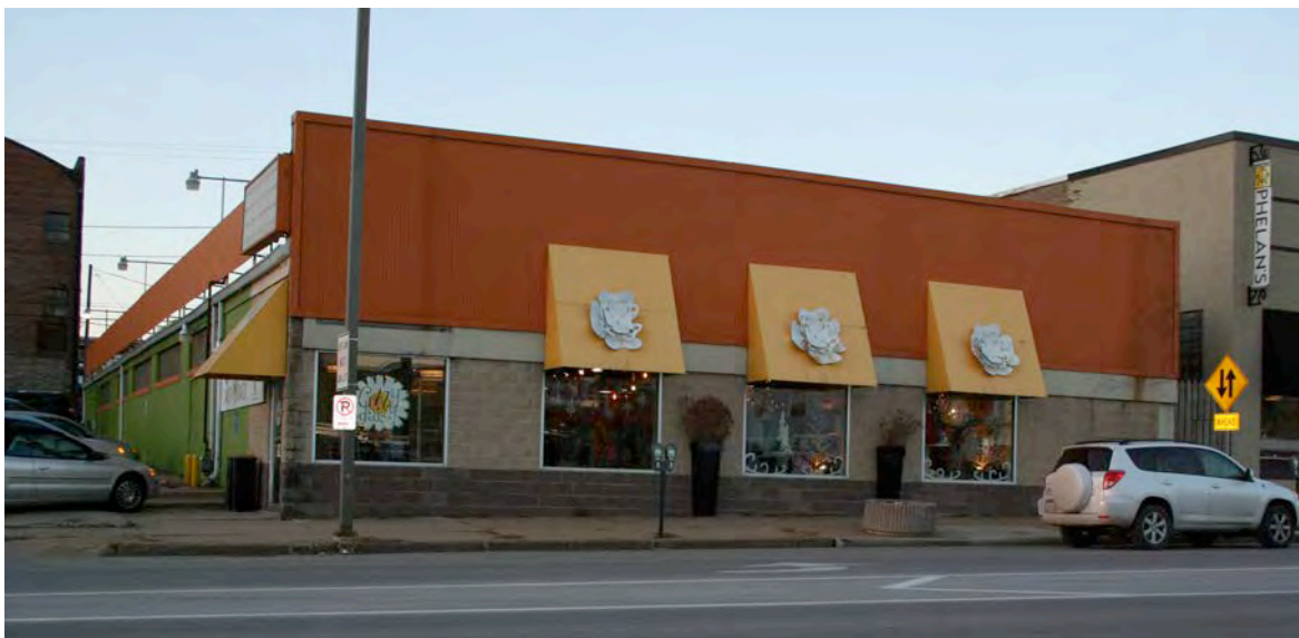
Image 40. 712 3 rd Avenue SE
