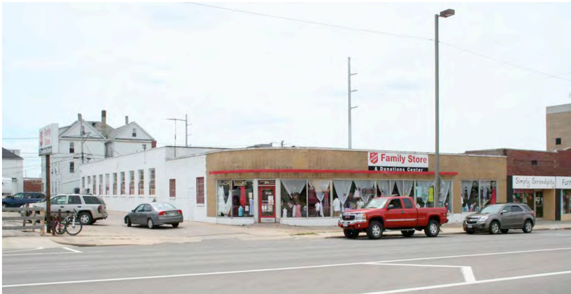
Image 48. 719 3 rd Avenue SE
