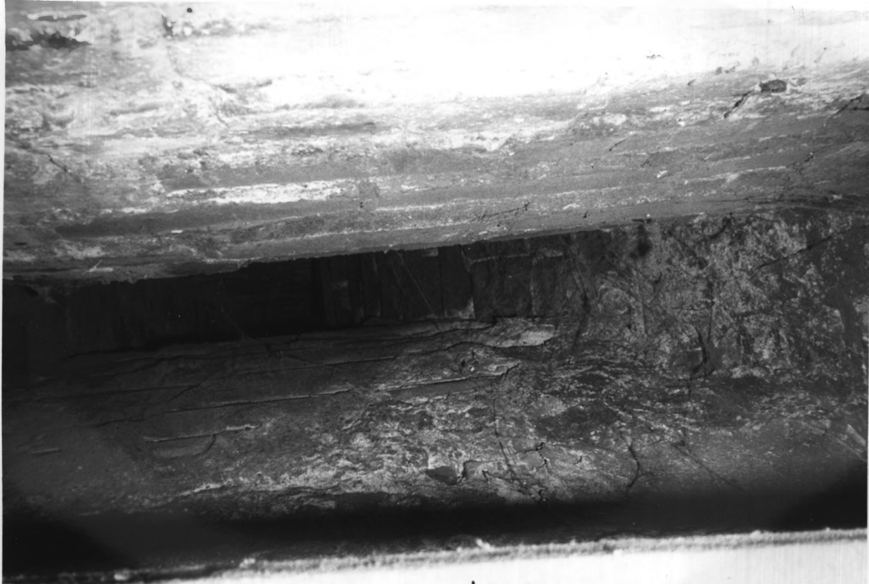
NJ 023 LEWIS ONDERDANK HOUSE - CHIMNEY FLUE, CELLAR
