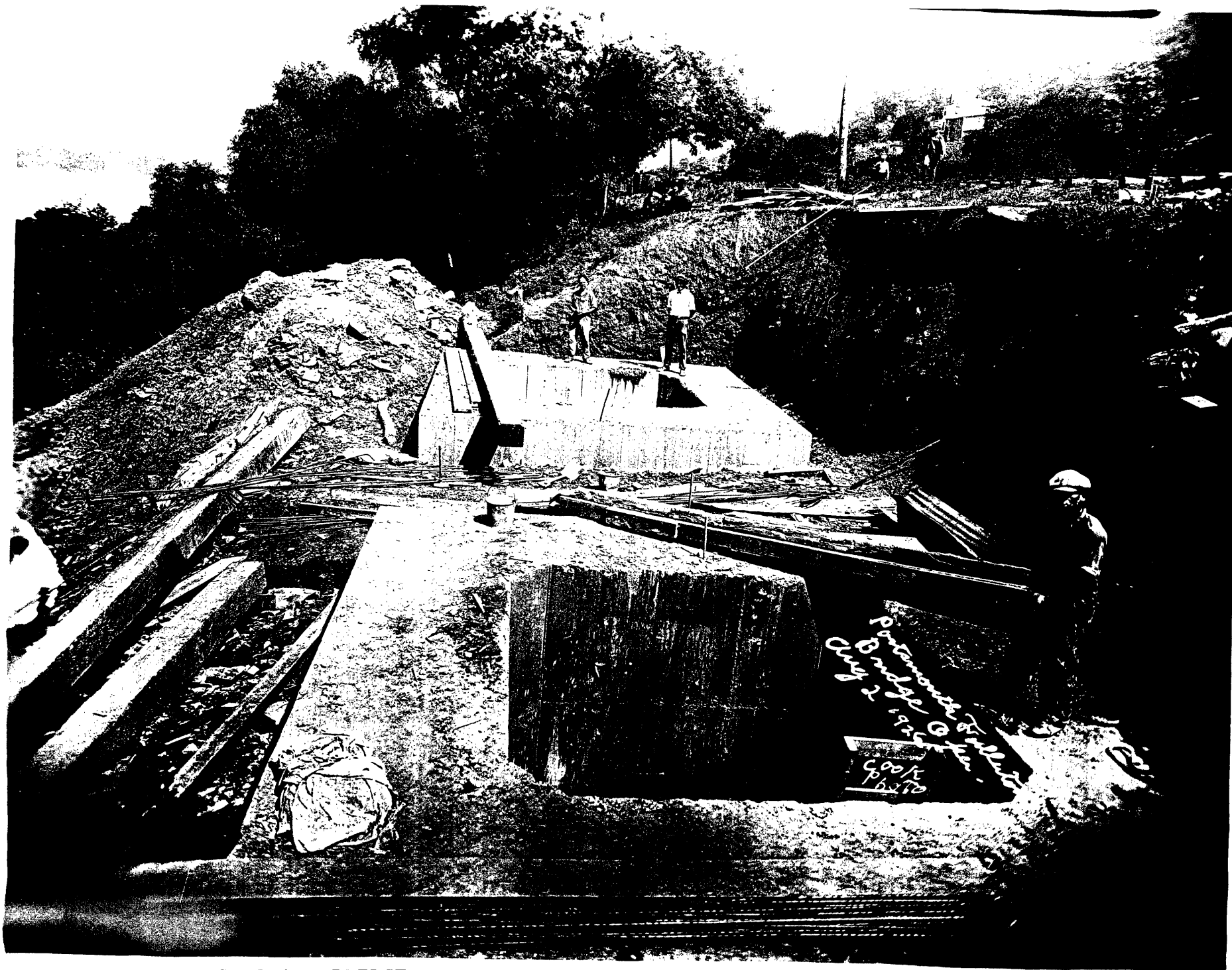
GENERAL U. S. GRANT BRIDGE SCIOTO CO., OH GREENUP CO., KY
