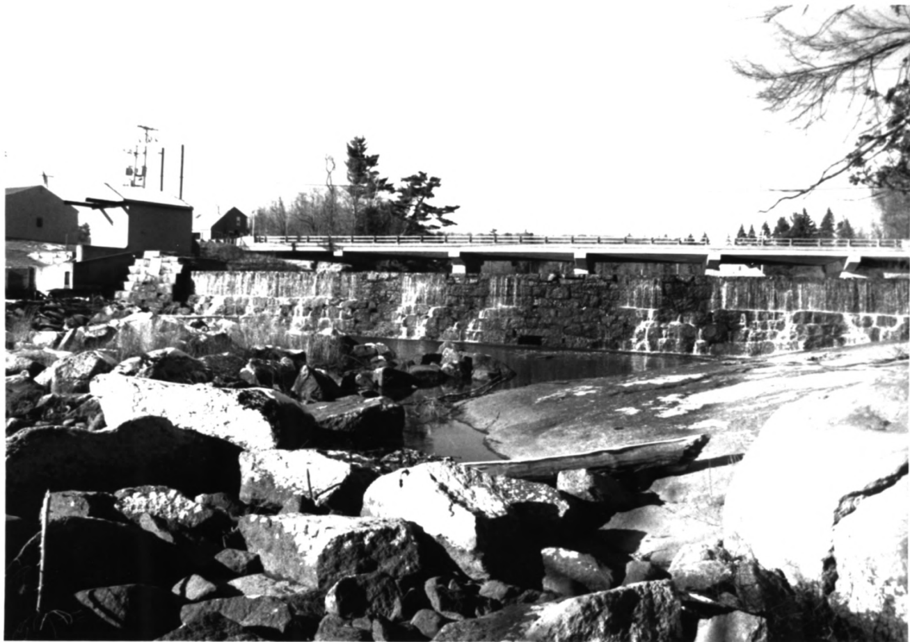
FRANKFORT DAM ; WALDO CO., MAINE
